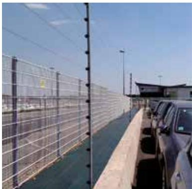
Rangées parallèles de câbles détectrices installées le long d'une clôture passive existante ou à créer. Le maillage de fils parallèles fixé à quelques centimètres du panneau de clôture passive est alimenté par un générateur haute et basse tension.
